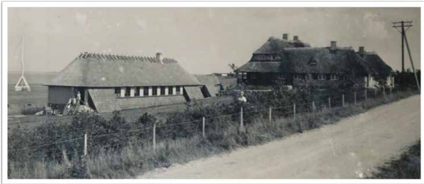
Figur 14 Den nye anneksbygning stod færdig i juni 1934. Masten på billedet er en telefonmast, der fører telefonsignalet til huset. Telefonmaster har ledningerne ordnet vandret. (De master, som leverer almindelig 220/230 Volt spænding, har masteledningerne monteret lodret over hinanden.)
