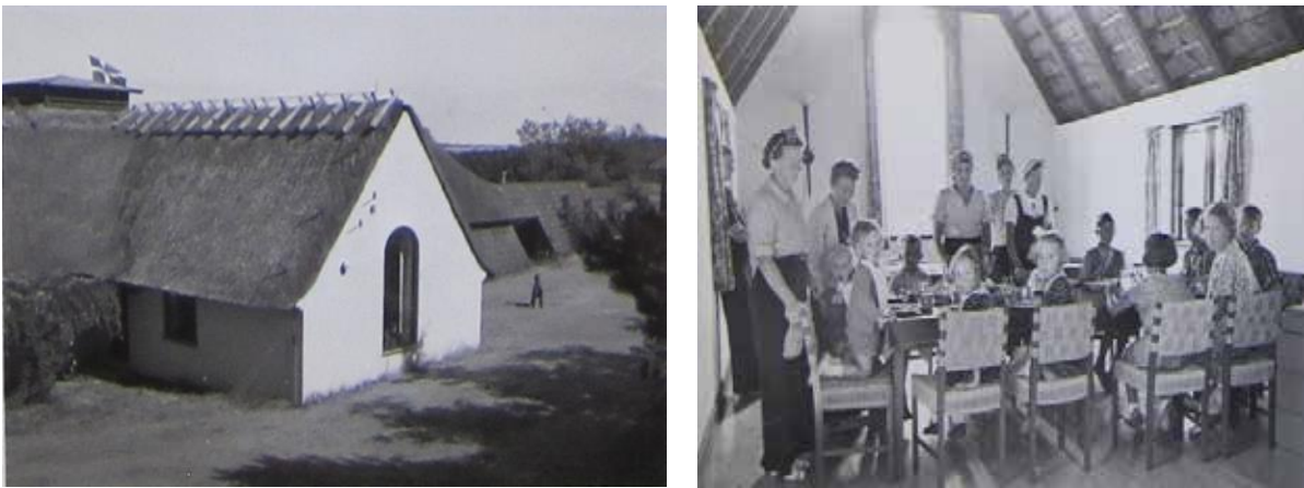
Figur 15 Tilbygningen fra 1939 ud-og indvendig
